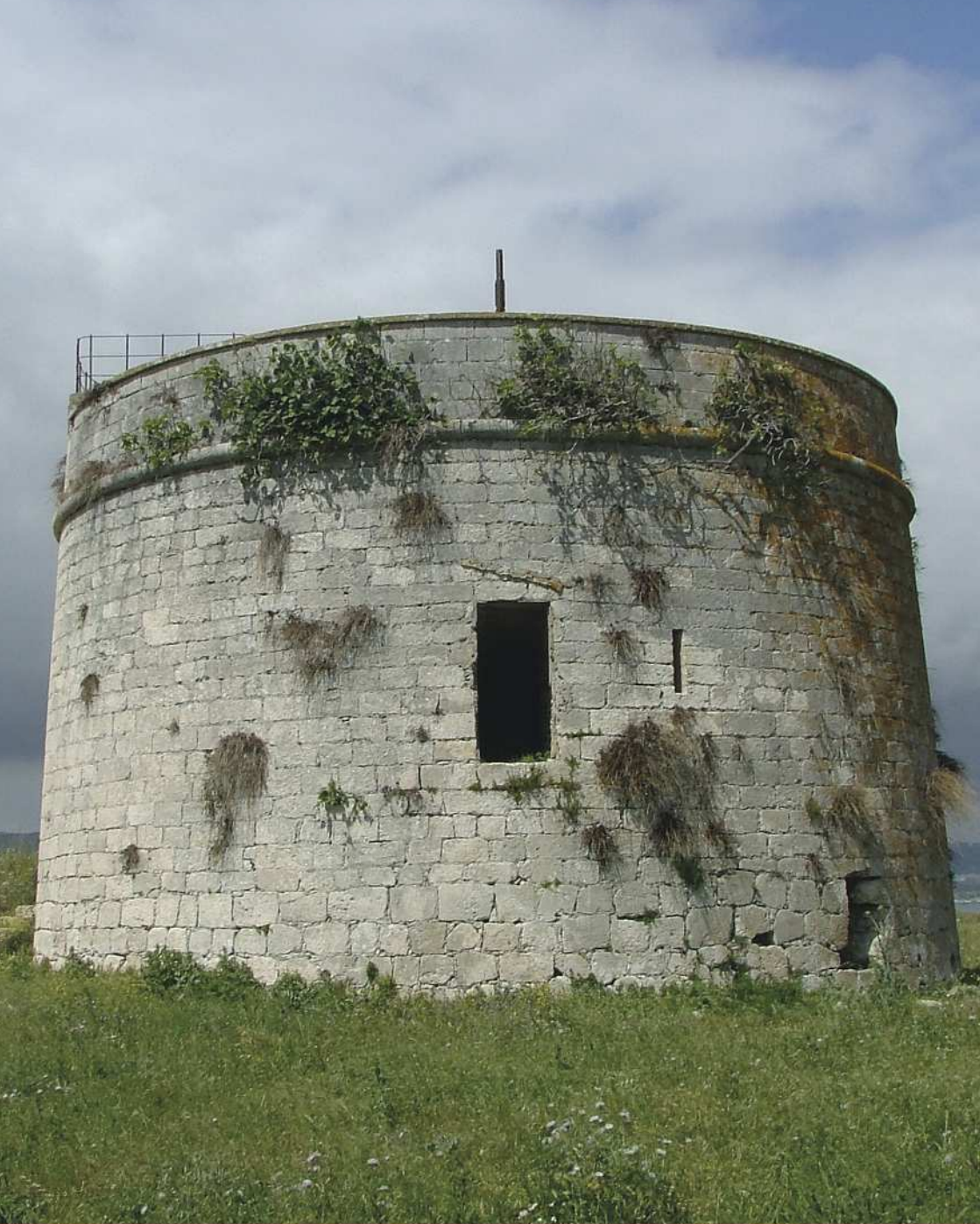
Magnisi: l'imponente "Martello tower" inglese prima dei lavori di ripulitura.
