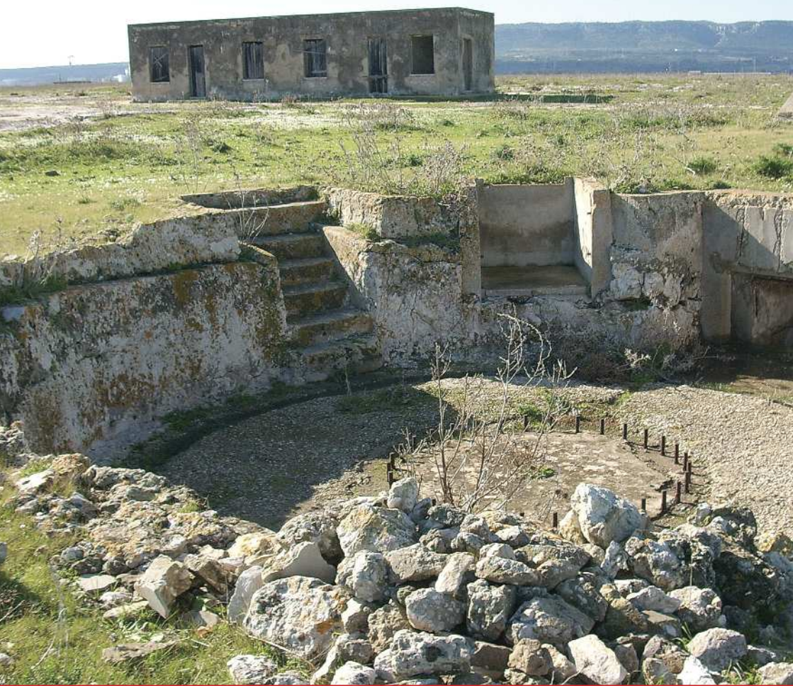
La Batteria A.S. 361. Vista della postazione in barbetta del cannone da 102/35 su affusto OTO.
